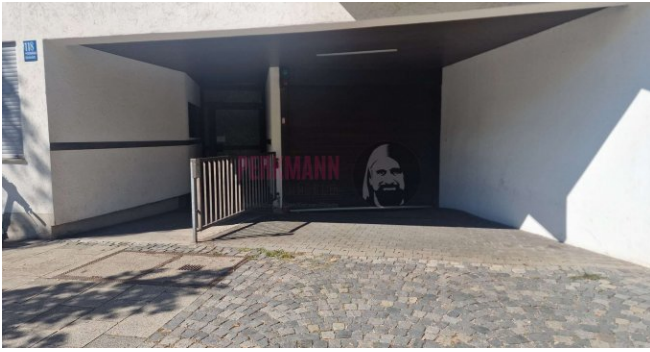
Hauseingang und Tiefgarageneinfahrt
