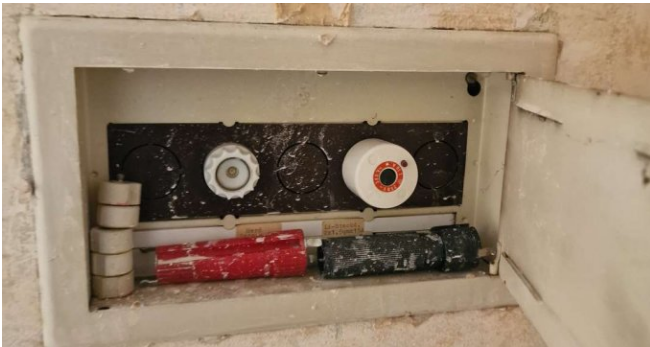
Sicherungskasten
