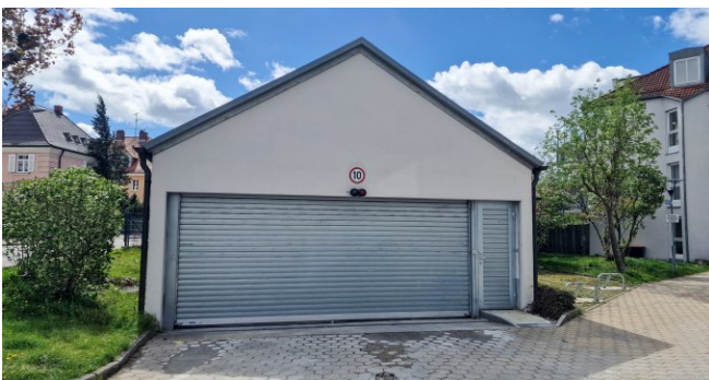
Einfahrt zur Tiefgarage
