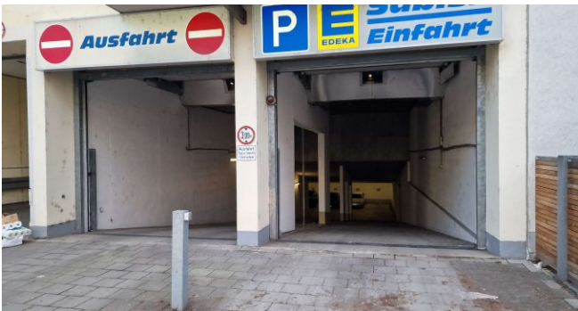
Einfahrt Passauer Strasse 36
