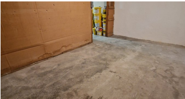
Keller mit Stromanschluss
