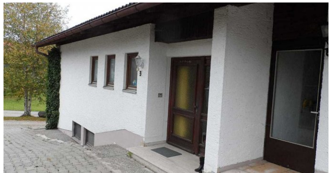
Eingangsbereich Wohnung Nr.2
