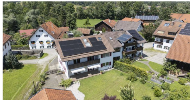
Luftbild mit PV-Anlage
