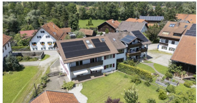
Luftbild mit PV-Anlage
